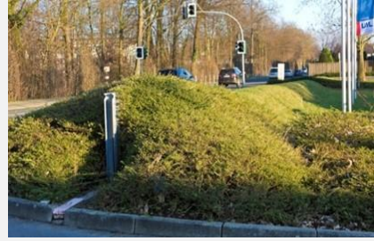
Beispiel: Damm und Schleusentor entlang eines Niederschlags-Hauptfließweges (Soest, Foto: K.PLAN)
