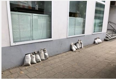
Beispiel: Temporäre Sicherung von Kellerfenstern (Foto: K.PLAN)
