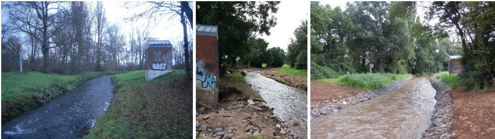
Abb.: Pegel Horschheim vor dem HW 21, kurz danach und nach dem Wiederaufbau (Quelle: Ertfverband).
