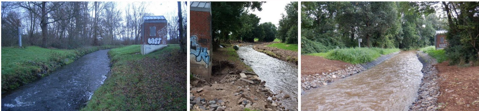
Abb.: Pegel Horschheim vor dem HW 21, kurz danach und nach dem Wiederaufbau (Quelle: Ertfverband).
