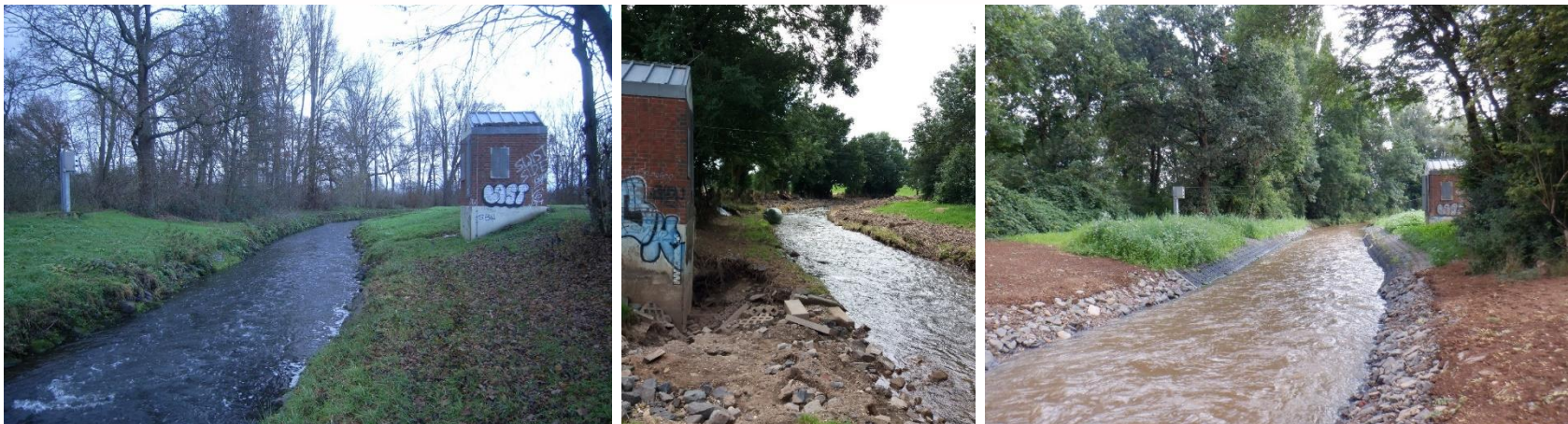
Abb.: Pegel Horschheim vor dem HW 21, kurz danach und nach dem Wiederaufbau (Quelle: Erftverband).
