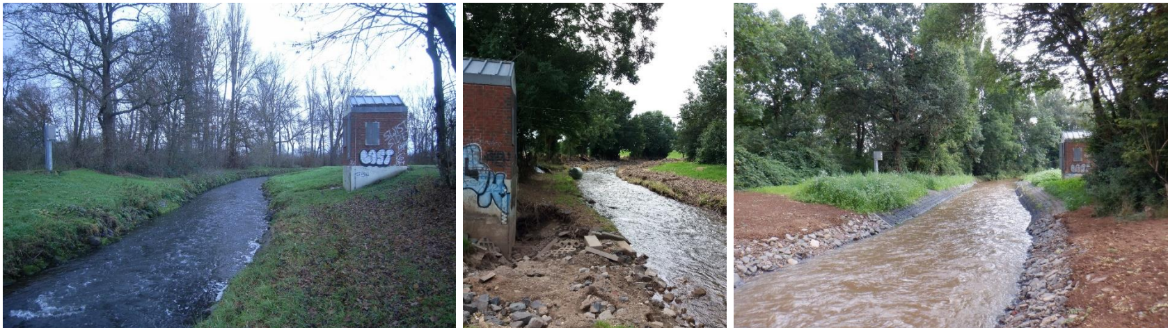
Abb.: Pegel Horschheim vor dem HW 21, kurz danach und nach dem Wiederaufbau (Quelle: Erftverband).
