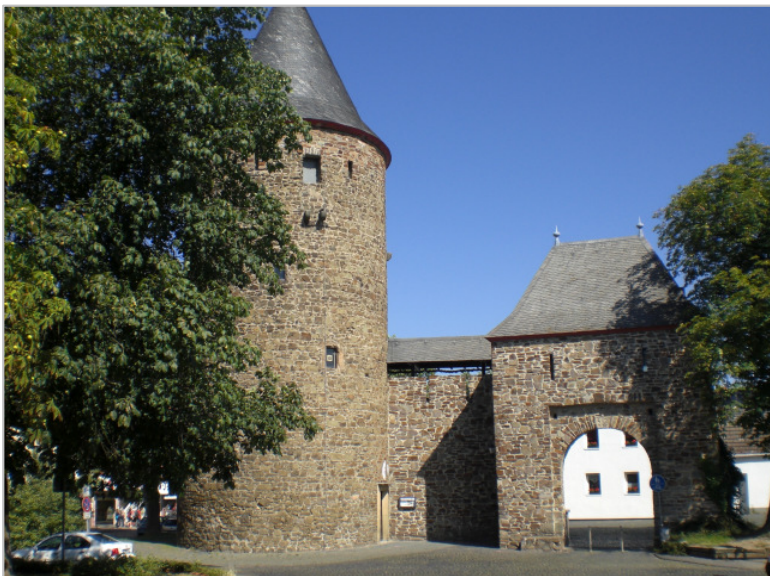
La tour de Wasem et la porte neuve
