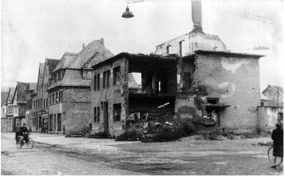
Die zerstörte Post an der Ecke Martinstraße/Vor dem Dreerer Tor. Foto: Stadt Rheinbach
