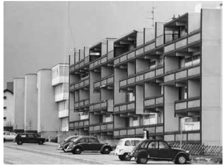
Rheinbach Südwest, ein neuer Stadtteil entsteht. Berliner Straße um 1980. Foto: Toni Orth
