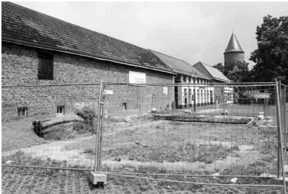
Die eingerichtete Baustelle mit der für das Römerkanalinfozentrum vorgesehenen Fläche
